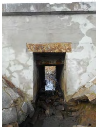
Propustek pod železniční tratí – pohled proti toku
