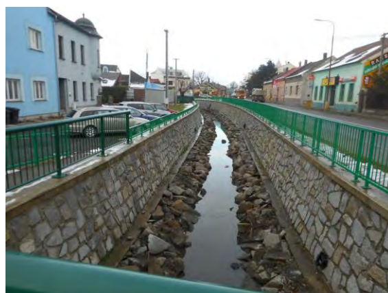
Mostek km 93,280 - pohled po toku
