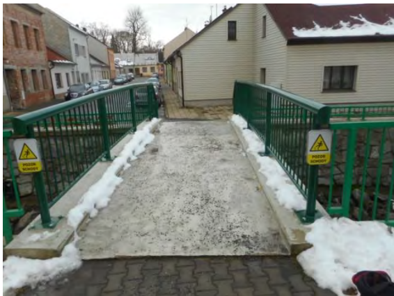
Mostek km 93,226 - detail, pohled z levého břehu
