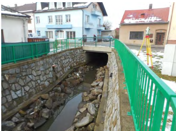
Pohled proti toku na začátek zaklenutí
