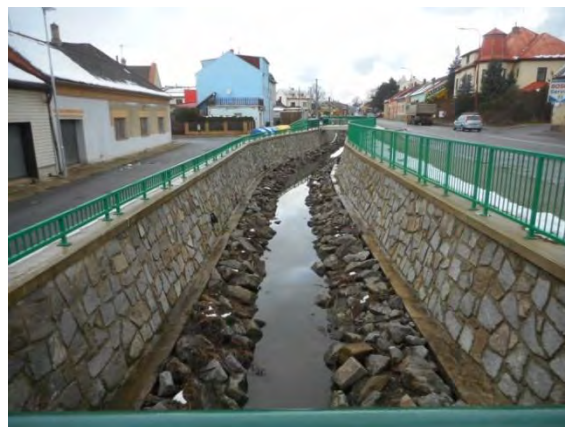
Mostek km 93,226 - pohled proti toku
