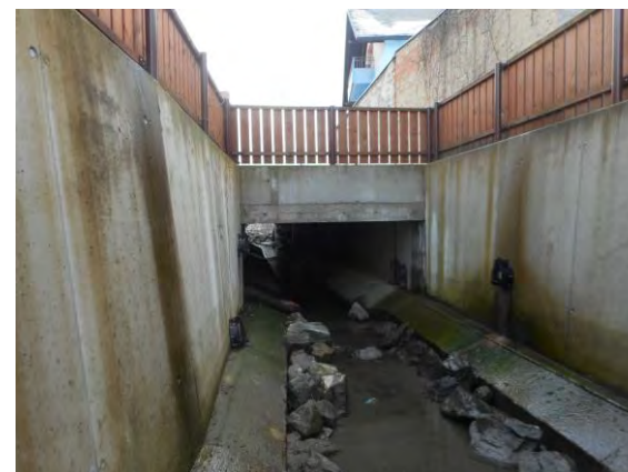
Pohled po toku na konec zaklenutí
