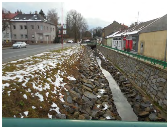
Mostek km 93,177 - pohled po toku
