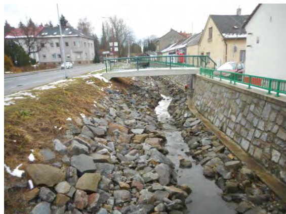
Mostek km 93,194 - pohled po toku
