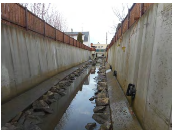
Pohled od konce zaklenutí proti toku
