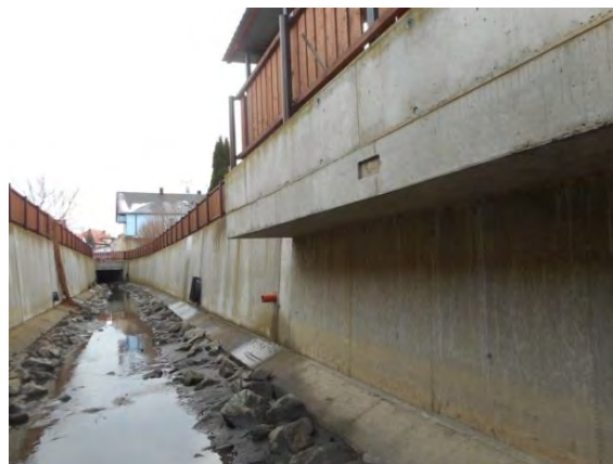
Pohled po toku na konec zaklenutí
