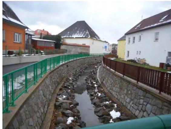
Mostek km 92,940 - pohled po toku
