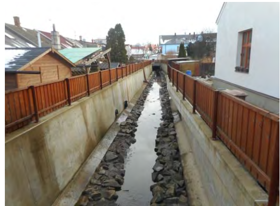
Mostek km 93,493 - pohled po toku
