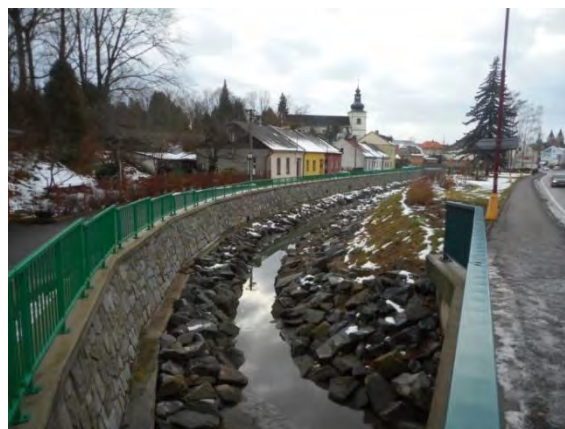
Mostek km 93,097 - pohled po toku
