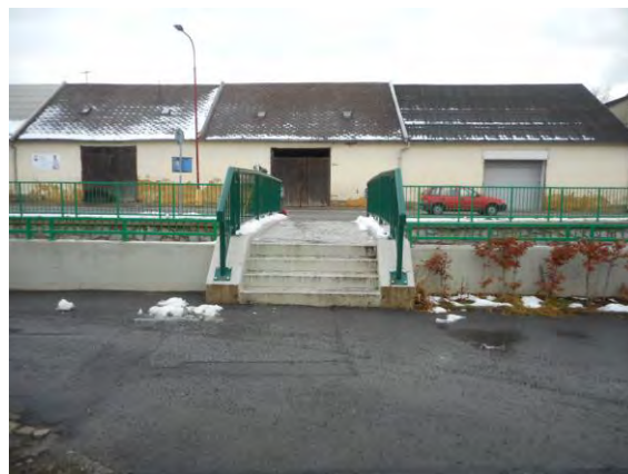
Mostek km 93,226 - detail, pohled z pravého břehu
