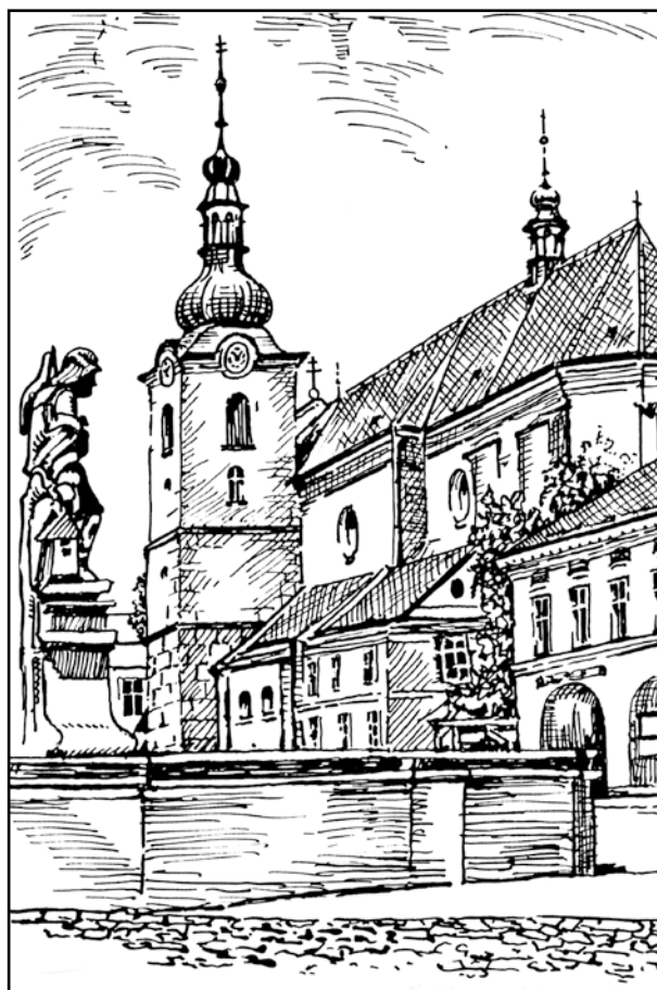
Původně gotický kostel Navštívení P. Marie je druhou doloženou nejstarší stavbou ve městě, a to z poloviny 13. století.
