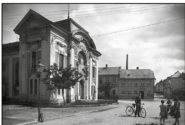
Židovská synagoga na dnešním Malém náměstí byla postavena Ernstem von Gotthilfem v roce 1902 v tehdy módním orientálním slohu. Padla za oběť nacistického běsnění za Křišťálové noci v listopadu 1938. Z jejího vybavení se toho příliš nedochovalo, snad jen několik ohořelých knih, které jsou vystaveny v muzejní expozici. Na místě synagogy dnes stojí čekárna autobusového nádraží.
