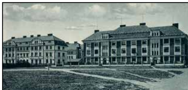
Družstevní výstavba v tzv. České čtvrti za reálnou školou byla výsledkem sebevědomé menšinové práce v nové republice. Stavělo se zde de facto až do začátku druhé světové války.
