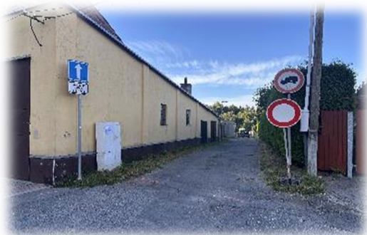
Obrázek 6: Ul. U Studeného potoka před rekonstrukcí
