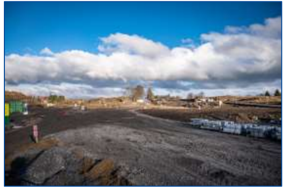
Obrázek 5 - Budovaná křižovatka obchvatu města Svitavy na silnici I/34 směr Olomouc
